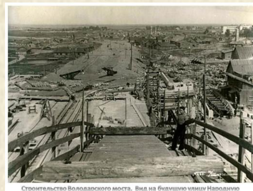
Строительство Володарского моста. Вид на будущую улицу Народную
